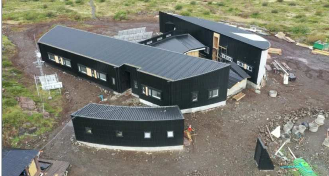
Guardería Paine Grande (noviembre 2022)
