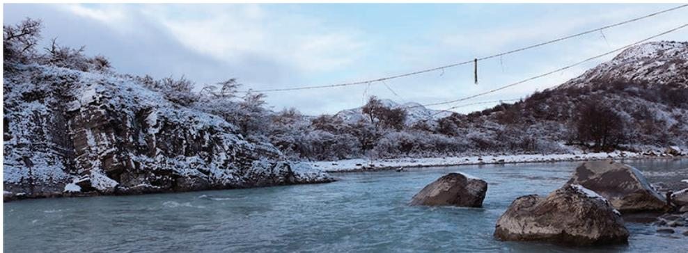
Restos de puente colgante sobre el río Pingo en su tramo superior, utilizado para cruzar ovinos. Estaba fabricado con alambre N°8 revirado. Foto: Nicolás Recabarren T.
